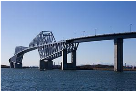
《東京ゲートブリッジ》
